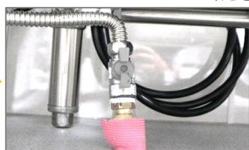
③ 給湯の元栓を開けて給湯器のスイッチをONしてください
