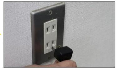
④冷蔵庫本体に電源がある場合は本体の電源OFF後、必ず電源プラグを抜いてください。
