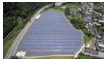
佐伯市床木地区太陽光発電設備
