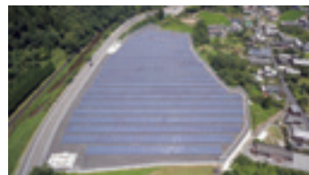
佐伯市床木地区太陽光発電設備
