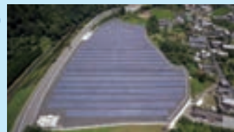
佐伯市床木地区太陽光発電設備
